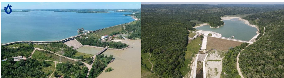
Acumularea Stâncă Costești (sursa foto: ABA-PB)
