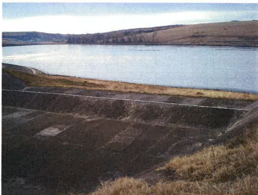
Foto nr. 8 – Descarcator de suprafata – prag deversor
