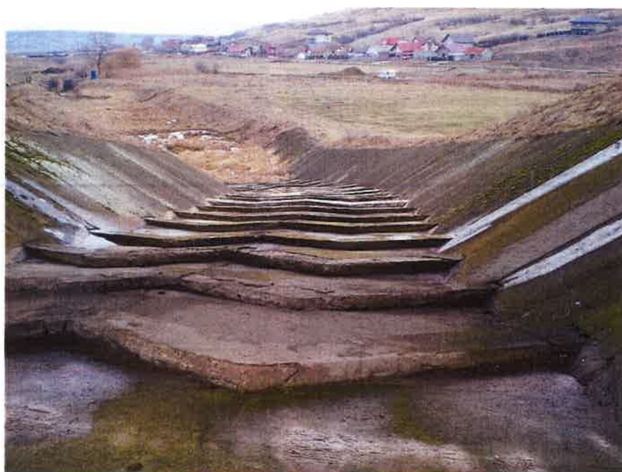
Foto nr. 9 – Canal rapid – Descarcator de ape mari
