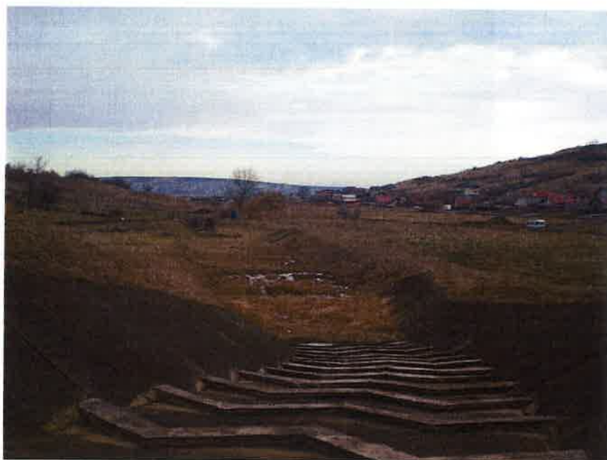
Foto nr. 11 – Colmatarea canalului de evacuare la DAM
