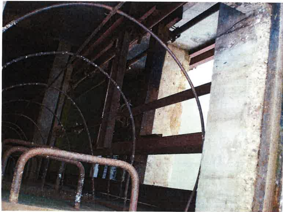
Foto nr. 6 – Vane pentru reglarea nivelului
