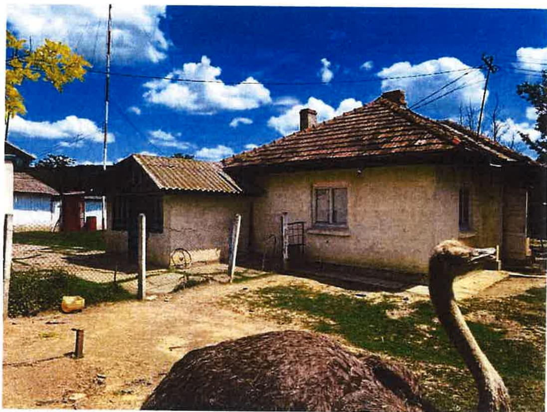
Foto 12.3 Vedere fațadă lateral-stânga
