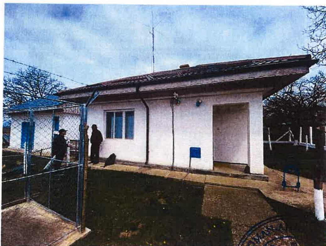
Foto 12.1 Vedere fațadă principală
