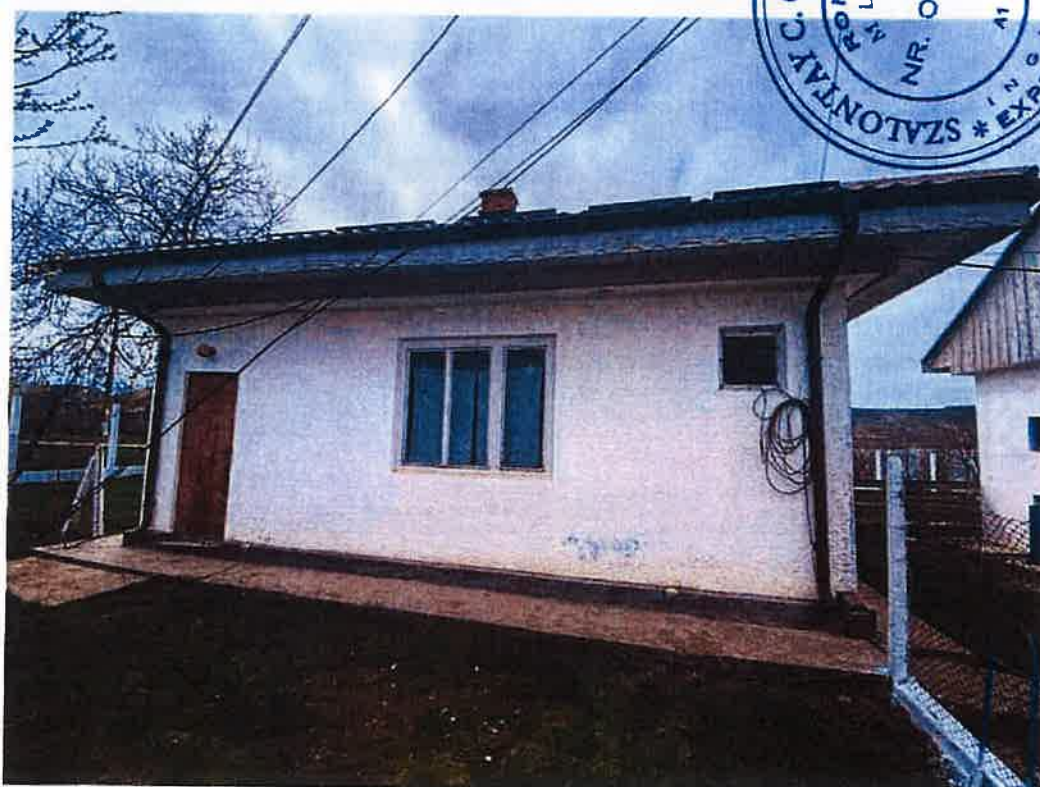
Foto 12.2 Vedere fațadă secundară
