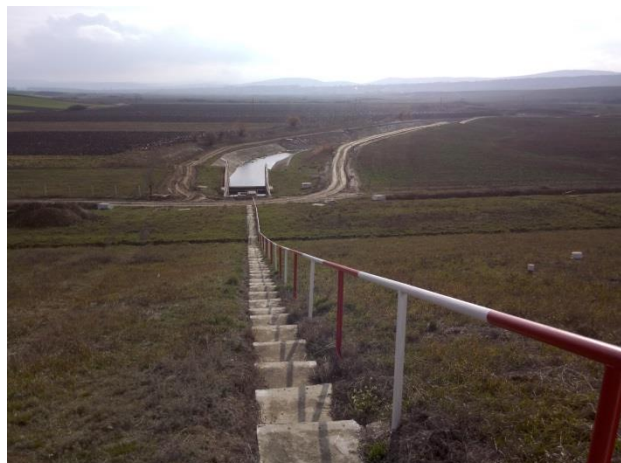
Foto 2 – Creșterea gradului de siguranță a acumulării Tungujei, pe râul Sacovăț, județul Iași – Vedere de pe coronamentul barajului spre canalul de evacuare al golirii de fund
