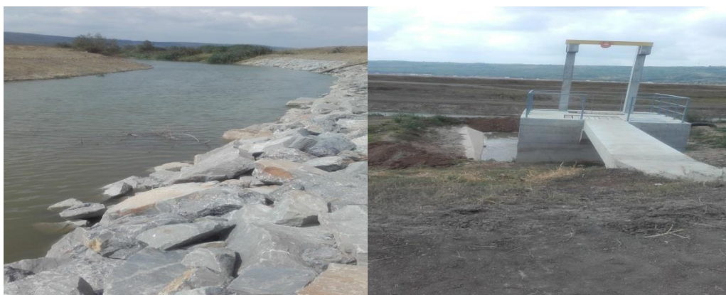
Foto 5 – Supraînălțare dig mal stâng râu Jijia amonte confluență râu Prut, județul Iași – a) Consolidare de mal cu piatră – b) Priză de apă pentru Jijia Veche
