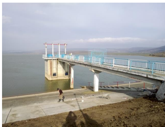
Foto 1 – Creșterea gradului de siguranță a acumulării Tungei, pe râul Sacovăț, județul Iași – Vedere de pe coronamentul barajului spre turnul de manevră și pasarela de acces
