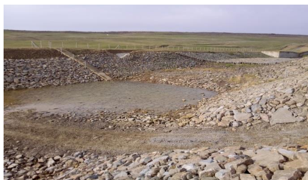
Foto 4 – Creșterea gradului de siguranță a acumulării Tungei, pe râul Sacovăț, județul Iași – Vedere dinspre aval a canalului de evacuare al descărcătorului de ape mari
