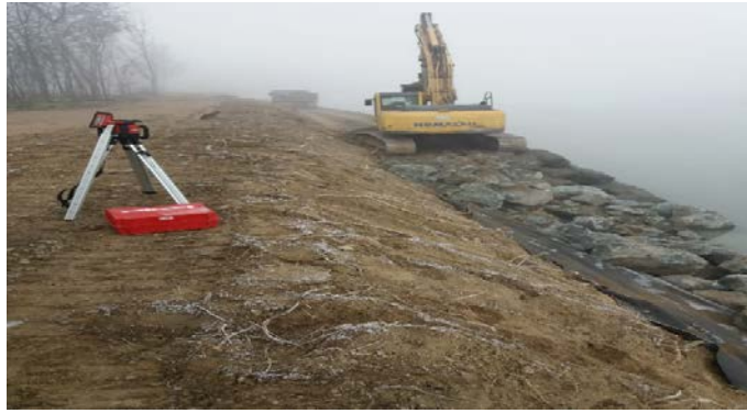
Foto 3 – Amenajare râu Siret în localitatea Șendreni, jud Galați-Consolidare de mal prism de anrocamente
