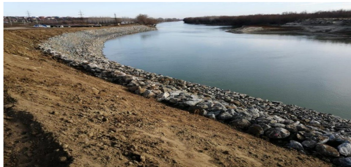
Foto 4 – Amenajare râu Siret în localitatea Șendreni, jud. Galați - Consolidare de mal prism de anrocamente
