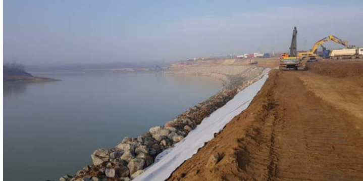
Foto 4 – Amenajare râu Siret în localitatea Șendreni, jud. Galați - Consolidare de mal prism de anrocamente
