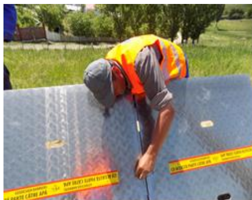
Montarea și demontarea barierei din panouri de tablă din aluminiu
