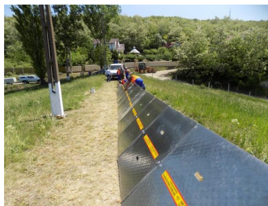
Montarea și demontarea barierei din panouri de tablă din aluminiu
