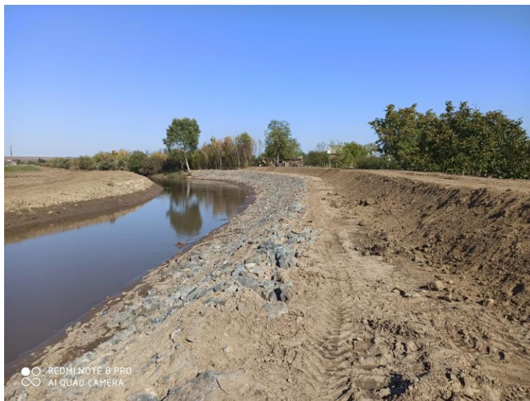
Lucrări pe cursul de apă Bârlad – Sistemul de Gospodărire a Apelor Galați
