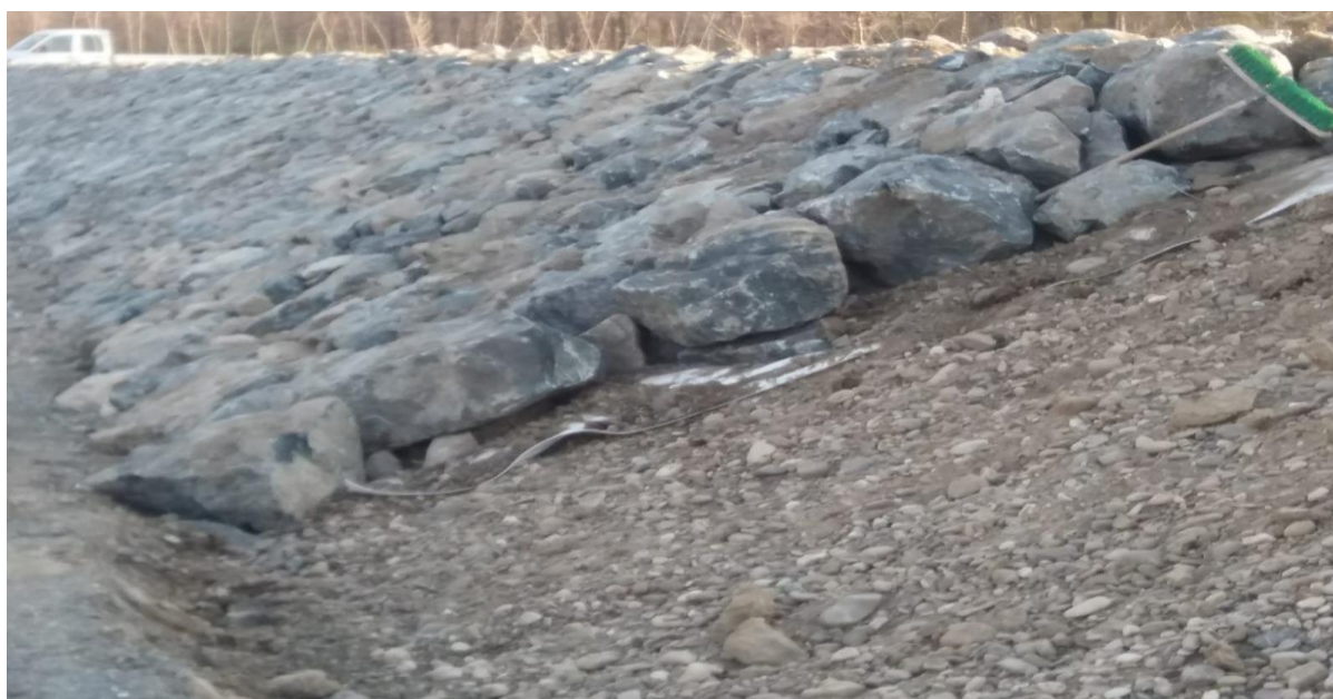
Foto 4 – Amenajarea raului Siret pe sectorul Homocea- conflueanta cu fluviul Dunarea, jud Galati Prelu de anrocamente
